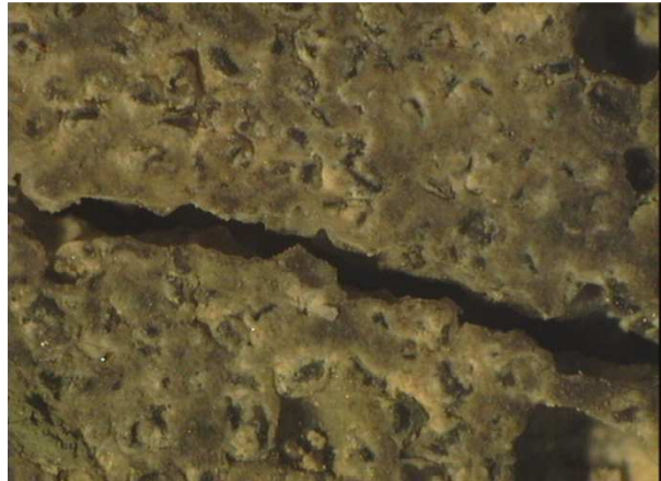
Figure 8 : Observation à la loupe d'une fissure témoin (sans bactéries), immergée après 4 mois d'expérimentation (Témoin-B)
